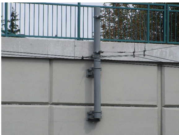
Obr. 27: Trakční vedení na zkráceném stožáru
