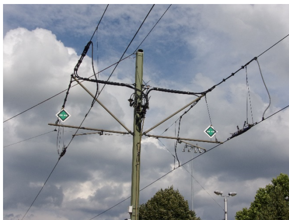
Obr. 43: Propojovací kabely na konzoli
