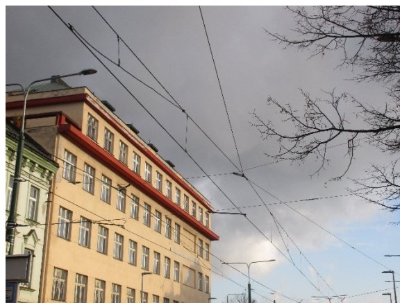
Obr. 10: Pevný bod řetězovkového vedení
