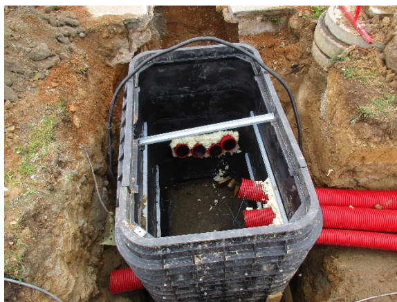
Obr. 47: Ochranná trubka v kabelové komoře
