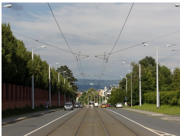
Obr. 1: Výměnný úsek prostého vedení
