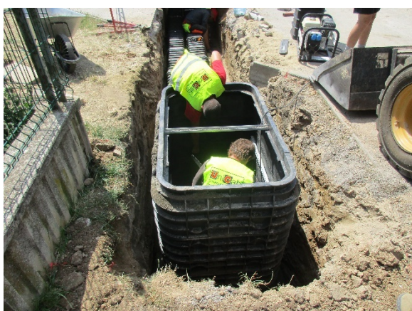
Obr. 48: Kabelová komora
