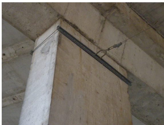
Obr. 28: Trakční vedení na mostním pilíři
