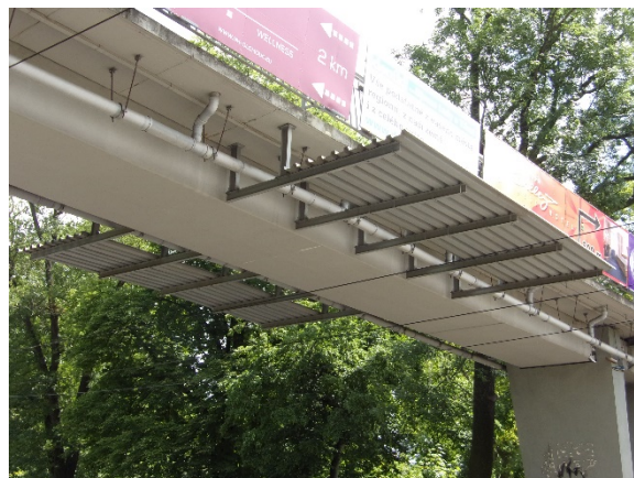
Obr. 12: Protidotykové zábrany upevněné na konstrukci mostu
