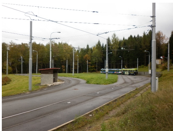
Obr. 4: Pevné kotvení řetězovkového vedení
