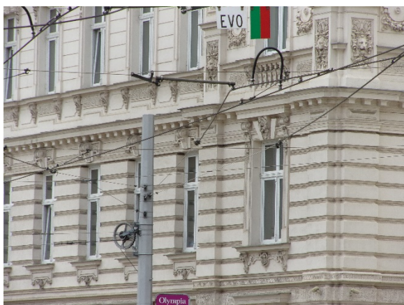
Obr. 3: Pevné kotvení prostého vedení
