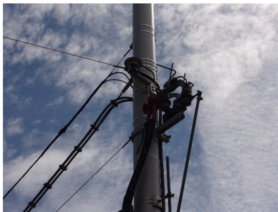
Obr. 37: Odpojovač U
