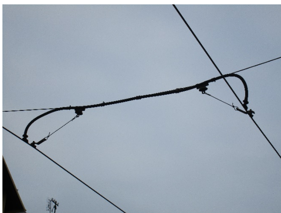
Obr. 44: Příčné propojení trolejí
