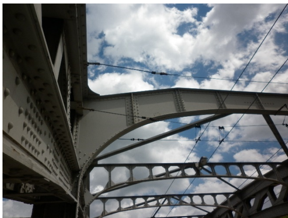
Obr. 25: Trakční vedení na mostní konstrukci
