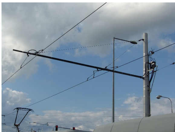
Obr. 42: Propojovací kabely na výložníku
