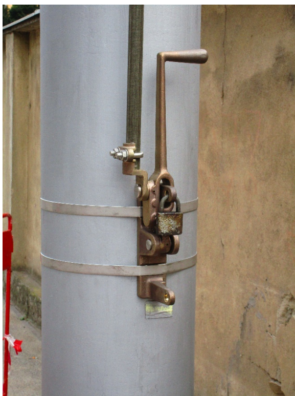
Obr. 38: Ruční pohon odpojovače
