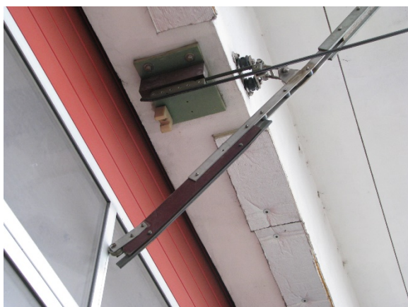
Obr. 13: Konstrukce sklopné troleje při spuštěných rolovacích vrátech
