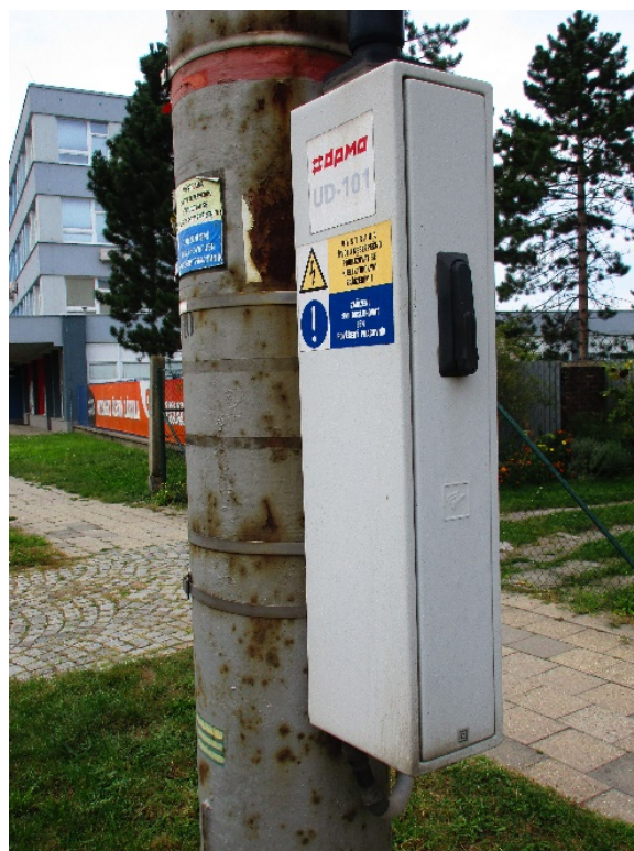
Obr. 39: Motorový pohon odpojovače
