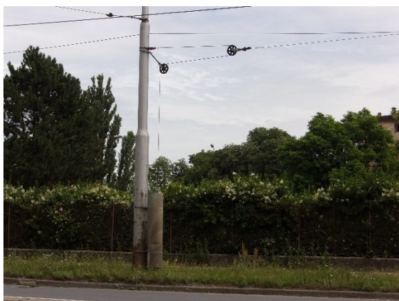
Obr. 5: Pohyblivé kotvení prostého vedení kladkostrojem v poměru 1:2
