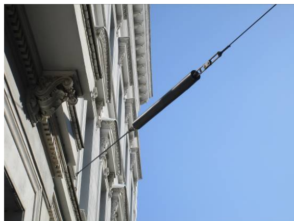
Obr. 8: Pružinový napínač
