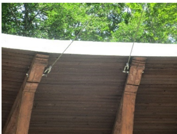
Obr. 23: Trakční vedení na dřevěné konstrukci
