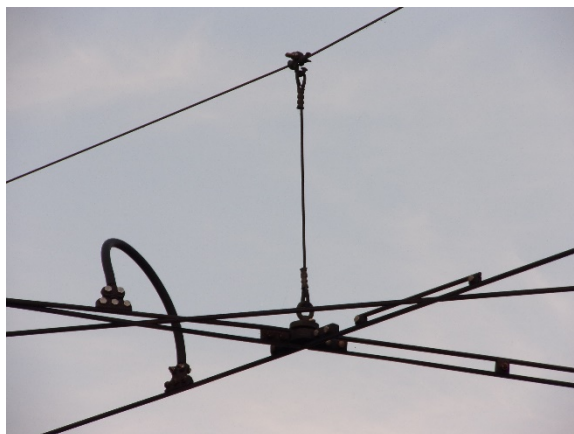
Obr. 16: Křížení pomocí stavitelného kříže
