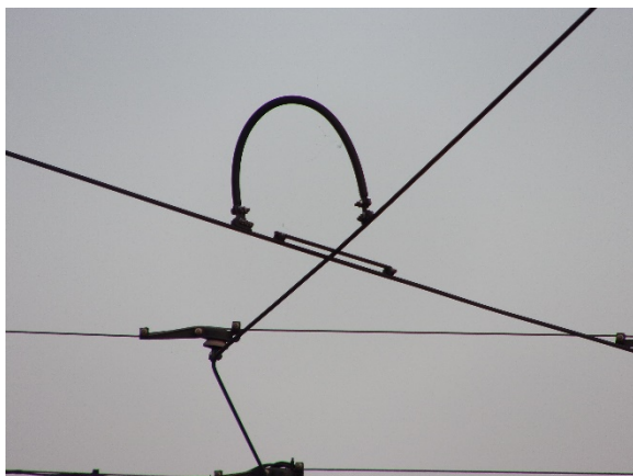
Obr. 15: Křížení pomocí přeponky do 50^\circ
