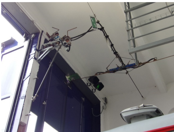
Obr. 36: Odpojovač I
