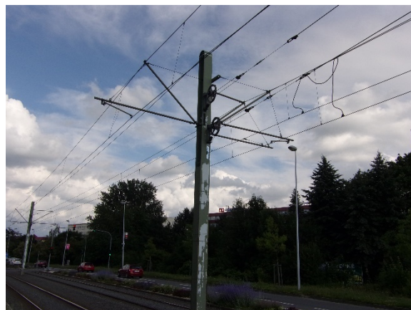
Obr. 6: Pohyblivé kotvení řetězzkového vedení západkovým kladkostrojem v poměru 1:3
