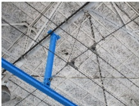
Obr. 26: Trakční vedení na nosné konstrukci budovy
